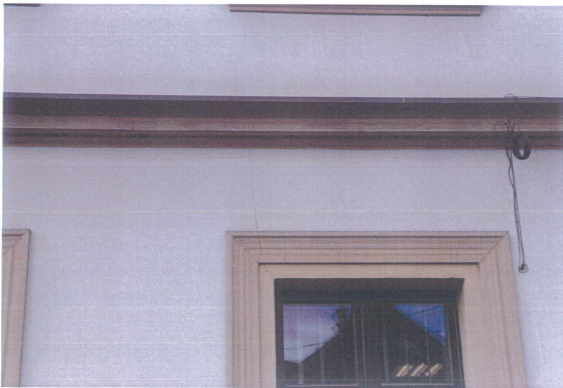
Elewacja frontowa – spękania przy oknie
