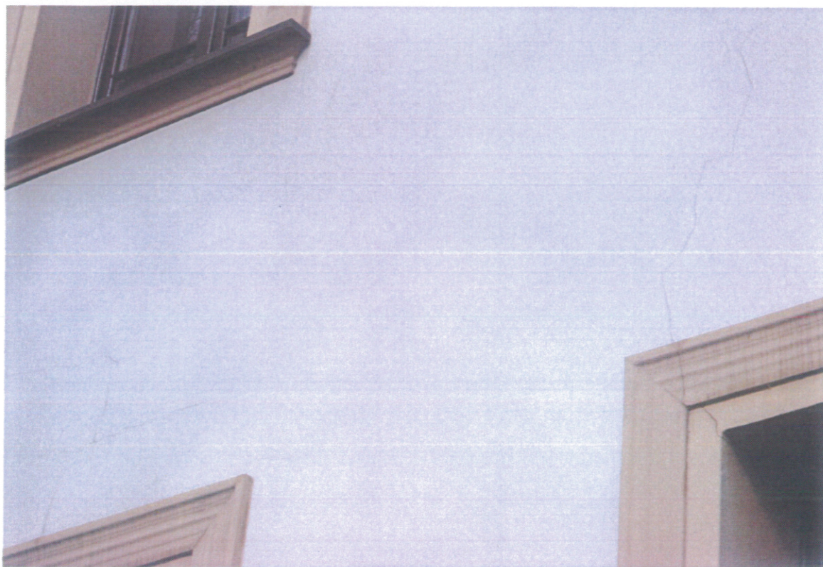
Mikrospękania tynku
